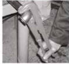
Ek parçasının boruya sıkılması
