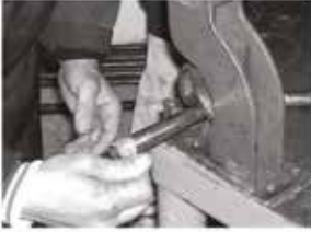
Boruya keten sarılması ve macun sürülmesi
