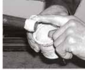
Boru ve ek parçasına macun sürülmesi
