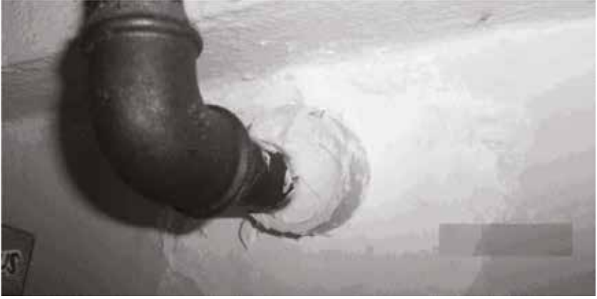
Şekil 20 Duvardan Kılıfı Boru Geçirme
