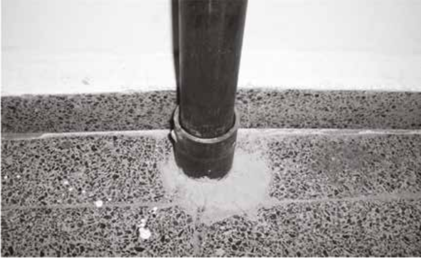
Şekil 19 Döşemeden Kılıflı Boru Geçirme
