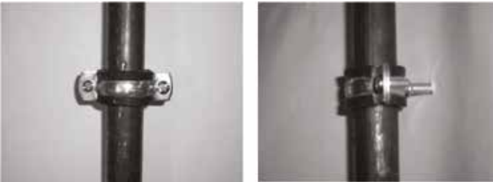
Şekil 24 Kelepçe Montajları
